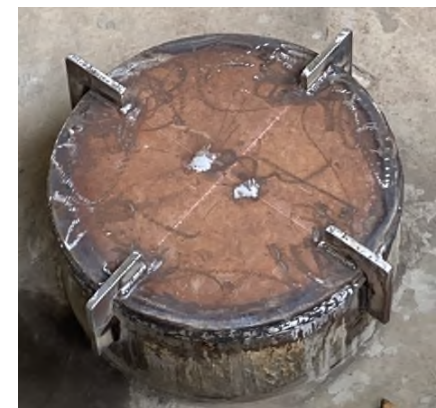
井戸への鉄板蓋取付状況
